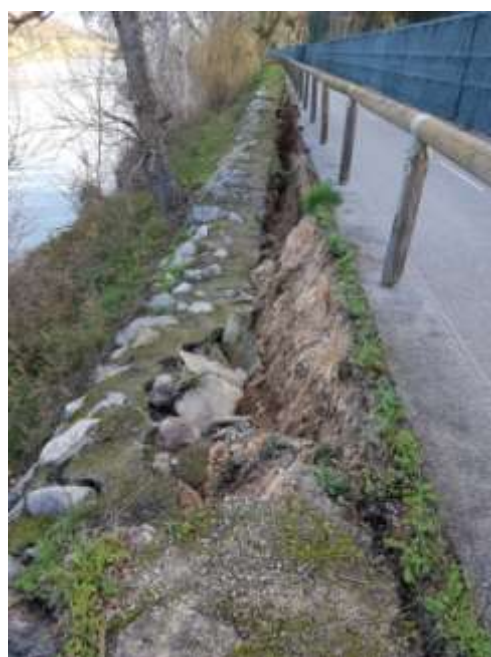
Photo 18 : Affaissement de la digue des Campinas à Canet-en-Roussillon
