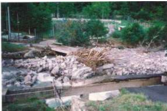
Photo 09 : Pont de la pisciculture coupé en rive droite. Les propriétés en rive droite ont le fond des Jardins effondrés
