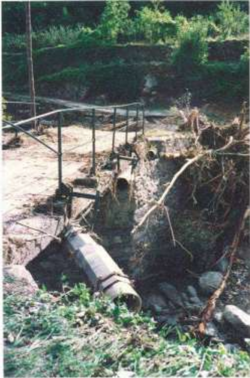
Photo 07 : Le pont de la Farge à Py sur la Rotja est détruit entre sa pile centrale et la rive droite. On note la présence de nombreux embâcles contre la pile
