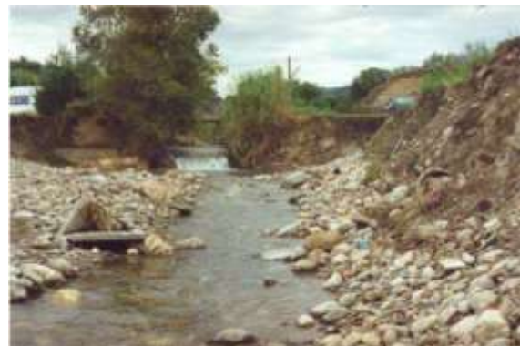
Photos 16 : Confluence du ravin Ballobère et de la Têt. Le lit passe de 5 m de largeur de fond à 25 m
