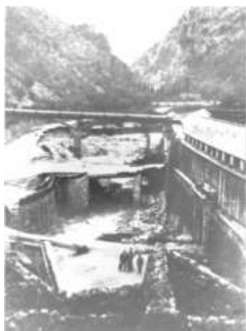
Photo 05 : Le pont du Cady en partie emporté par la crue à Villefranche-de-Conflent juste en amont de sa confluence avec la Têt
