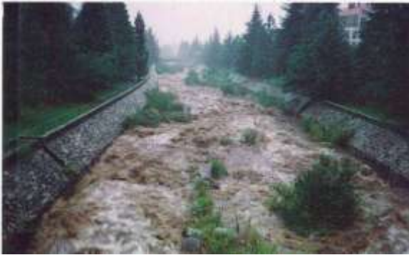
Photo 11 : Pont des Thermes à 17h vers l'aval du Cady, la végétation va bientôt être emportée
