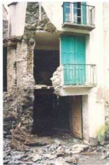
Photo 14 : Le torrent du Routès à Catllar longeant cette maison l'a en partie détruite sur 2 niveaux
