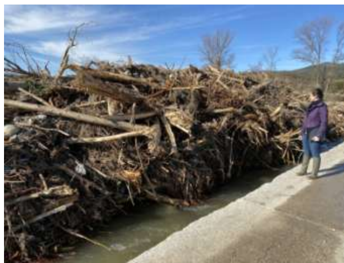
Photo 20 : Embâcle au passage à gué de Néfiach
