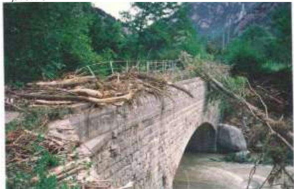
Photo 10 : Canal de la centrale électrique de Villefranche-de-Conflent en aval du Mas Py à Fulla sur la Rotja. Canal envasé et encombré de bois déposés par la crue
