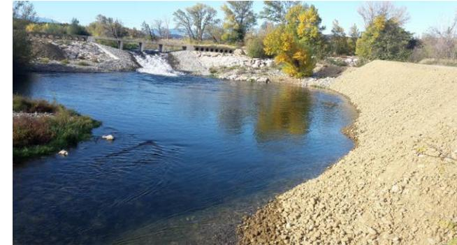
Réinjection de sédiments en RD de la Têt à l'aval du PG de Néfiach
