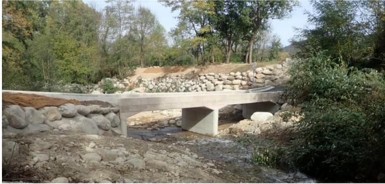
En 2022 à la fin des travaux (vue vers l'aval). Les buses ont été remplacées par un pont cadre
