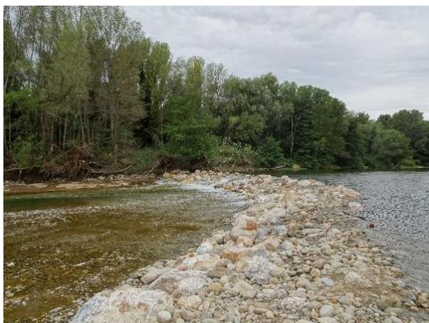
Figure 43 : Seuil temporaire du Soler en amont du seuil du Soler 3
