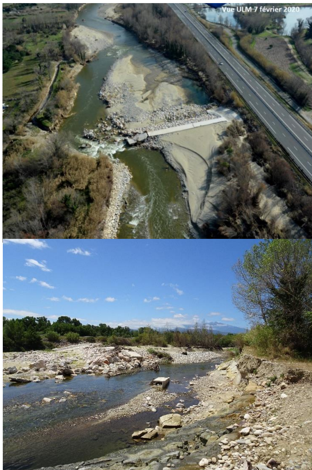
Figure 10. Illustration du seuil de Millas détruit Source : Association Icare 2020 (haut) ; Setec, Hydratec, 2021 (bas)
