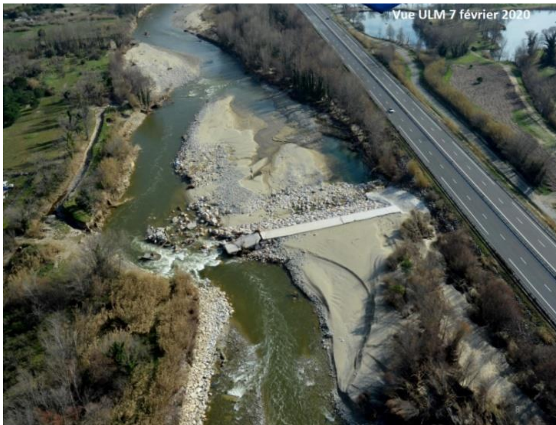
Figure 1. Effondrement partiel du seuil de Millas Source : Association Icare, 2020
