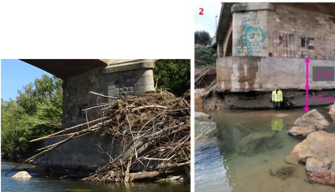
Figure 12 . Piles déchaussées du pont de Millas (Photographies CD66 à droite, Setec Hydratec à gauche, 2021)
