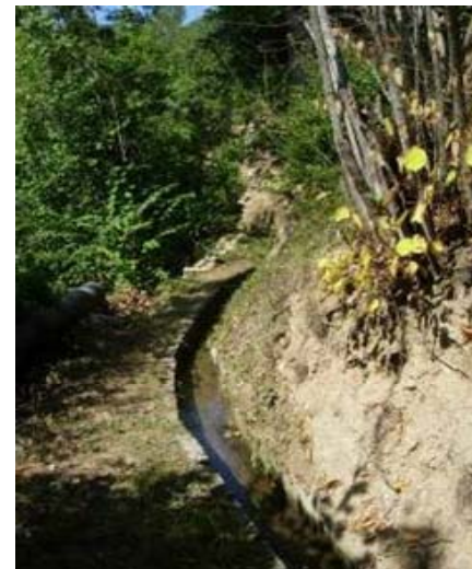
Section bétonnée du canal
