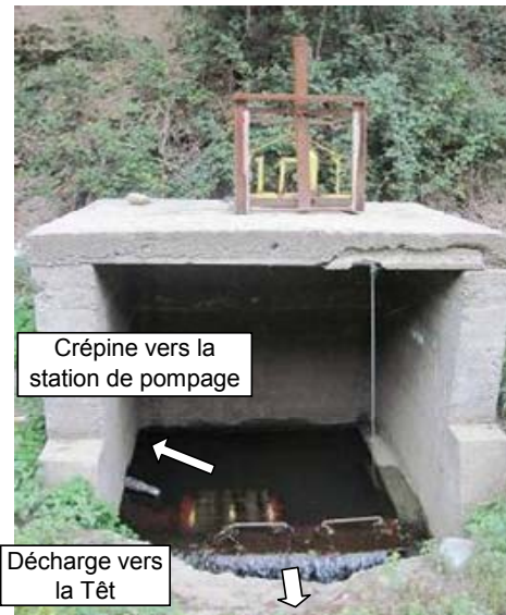
Station de pompage avec filtres
