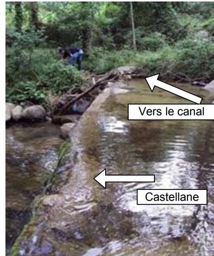
Regulation de la prise par deverse sur une portion limitée en hauteur
