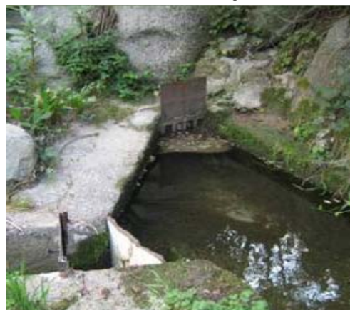
Vanne de décharge
