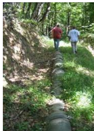
Section busée du canal
