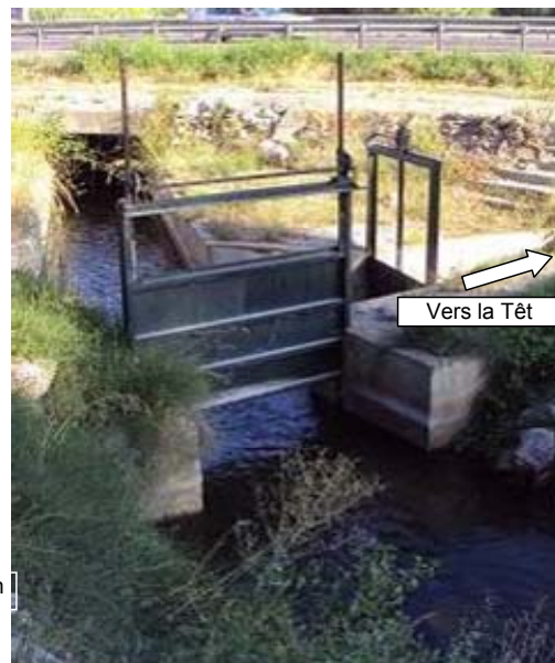
Vannes de décharge
