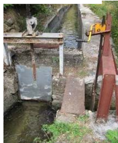
Vanne de décharge en aval de la prise
