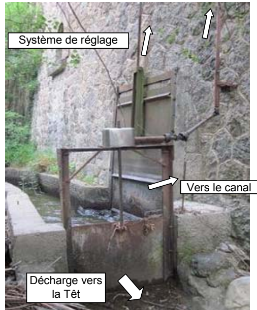
Vannes de décharge et de prise
