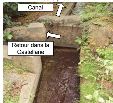
Vanne de décharge environ 250 m en aval de la prise
