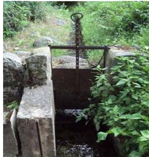
Vanne de décharge environ 250 m en aval de la prise
