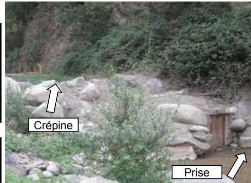
Système de prise et de crépine
