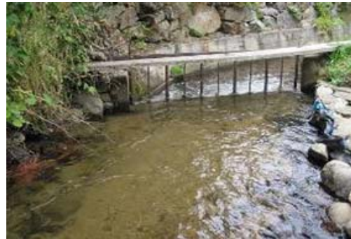
Vanne de décharge en aval de la prise
