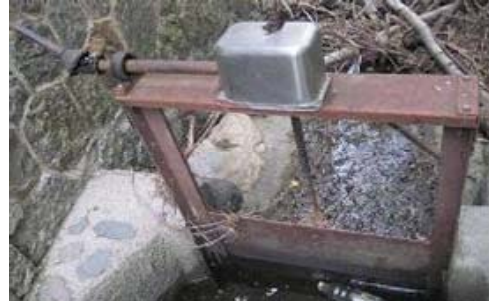
Réglage de la vanne actionnable en hauteur
