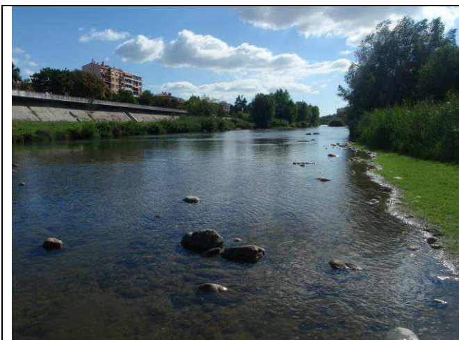
Photo 17 : T7 Aperçu général de la station
