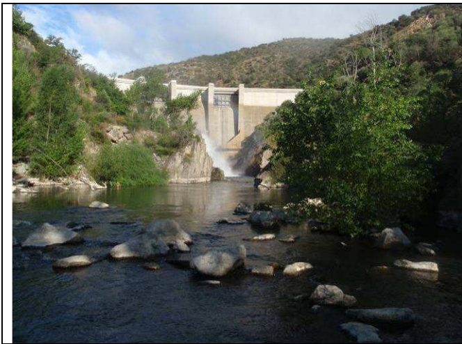
Photo 12 : T5 Aperçu de l'amont de la station
