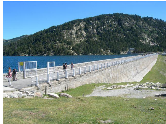
Image 1 : Barrage des Bouillouses. Source : les-pyrenees-orientales.com
