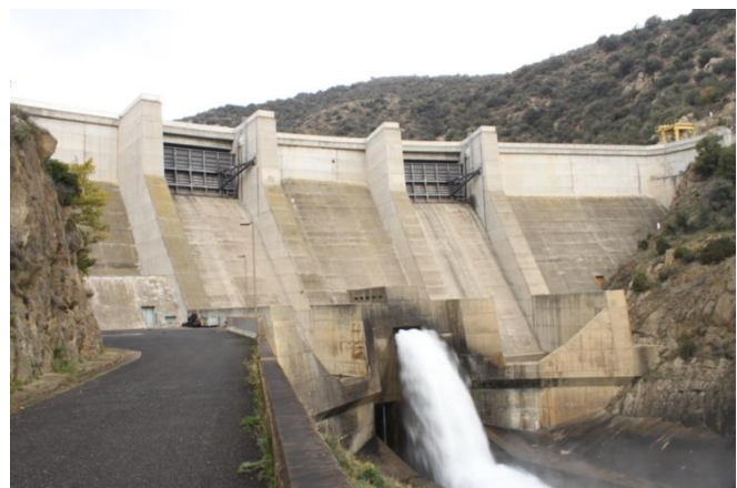
Image 2 BARRAGE DE VINÇA source SMTBV
