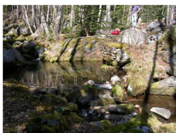
Prise d'eau (canal partant sous l'ouvrage en pierres)
