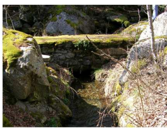
Vue de l'amont du canal (aval immédiat muret en pierre)
