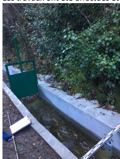
Cuvelage du canal et pose d'une échelle limnimétrique
