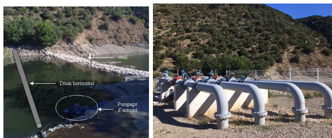
Visualisation de la station de pompage en aval du barrage de Vinça (photos SMBVT)
