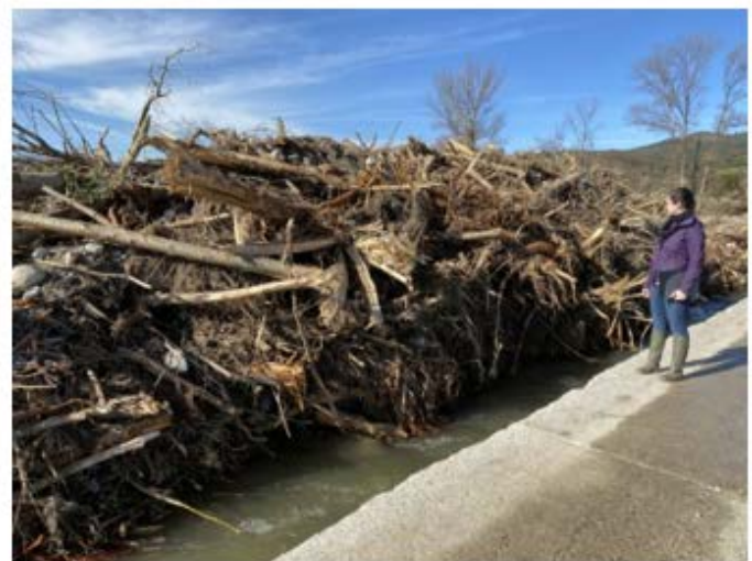
Photo 20 : Embâcle au passage à gué de Néfiach
