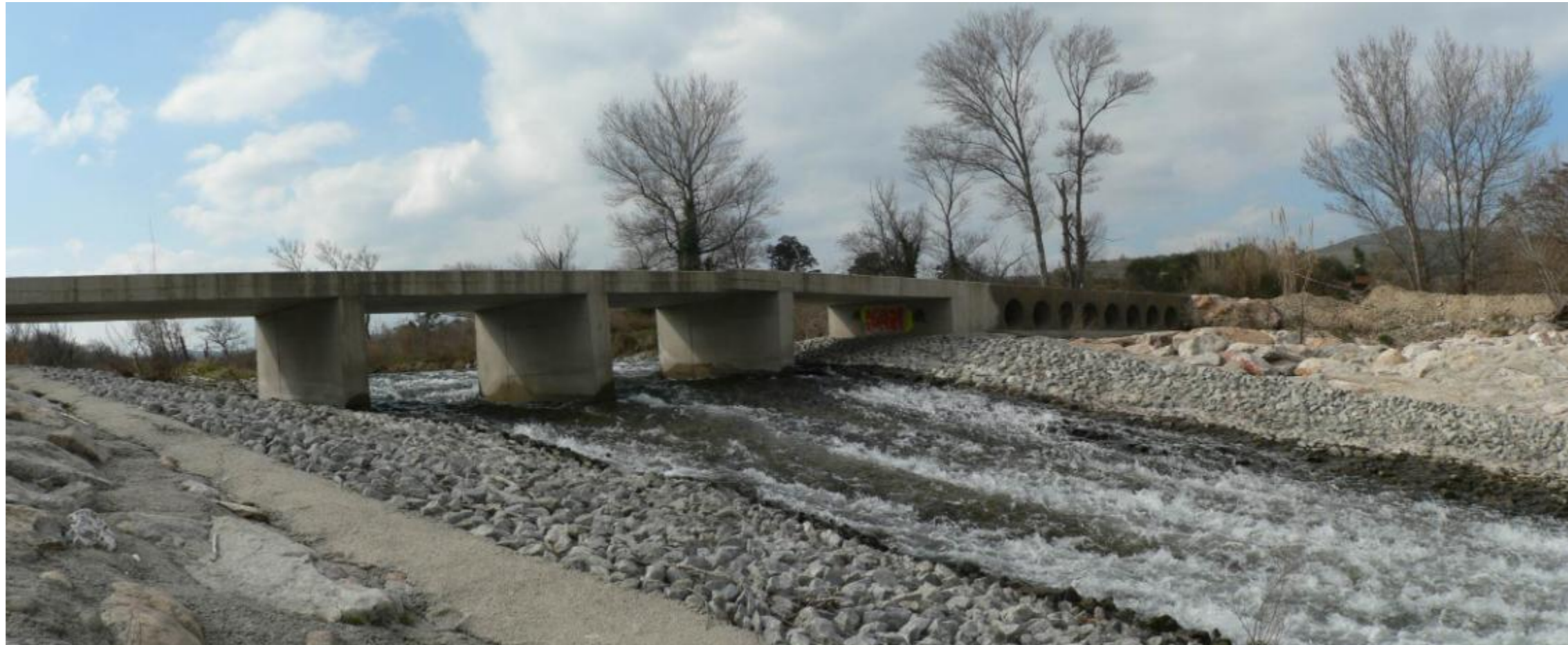
Passé à poisson vue vers l'amont
