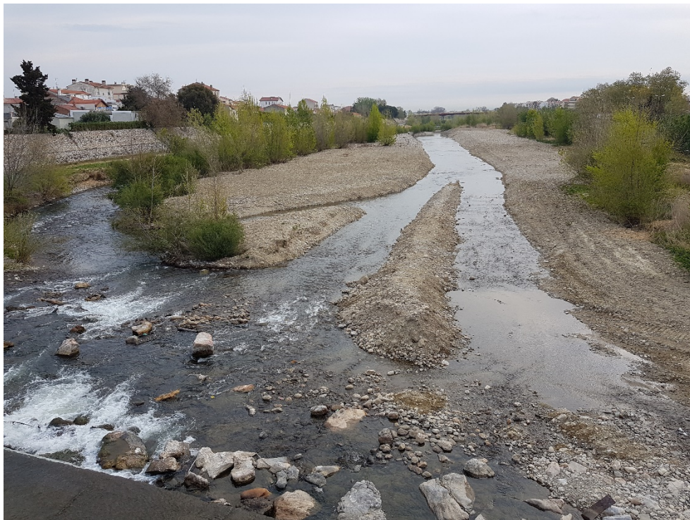
Figure 5 : La Têt dans la traversée de Perpignan (en aval du pont Joffre) suite aux travaux d'entretien de février 2019
