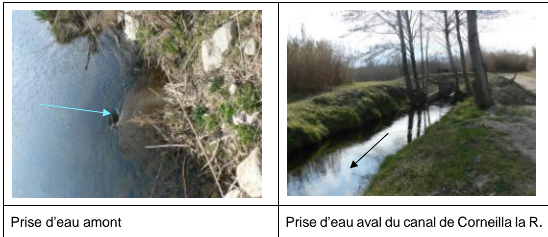
Figure 13 : Photographies du seuil de Millas et de la prise d'eau du canal de Corneilla la R.
