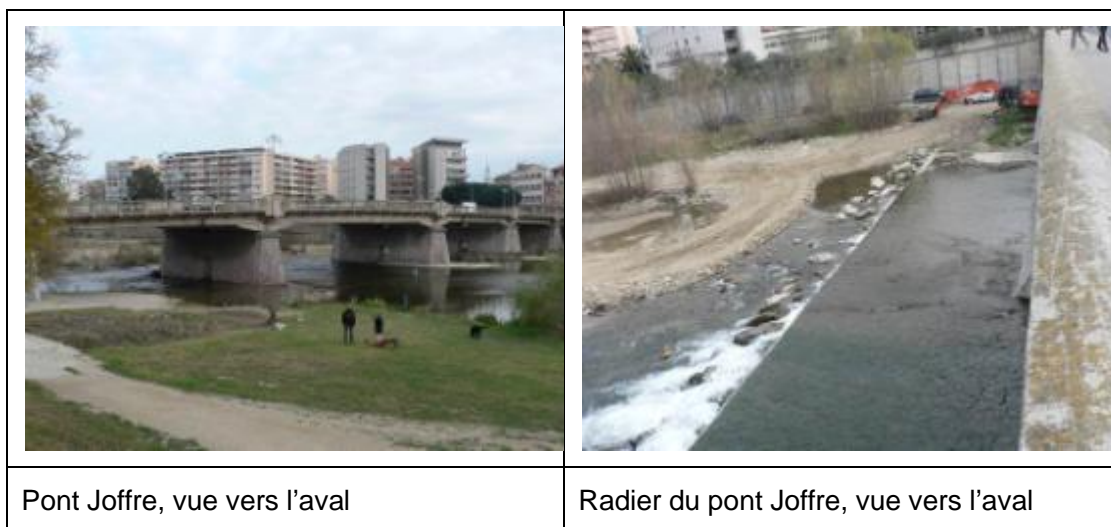
Figure 11 : Photographies du pont Joffre
