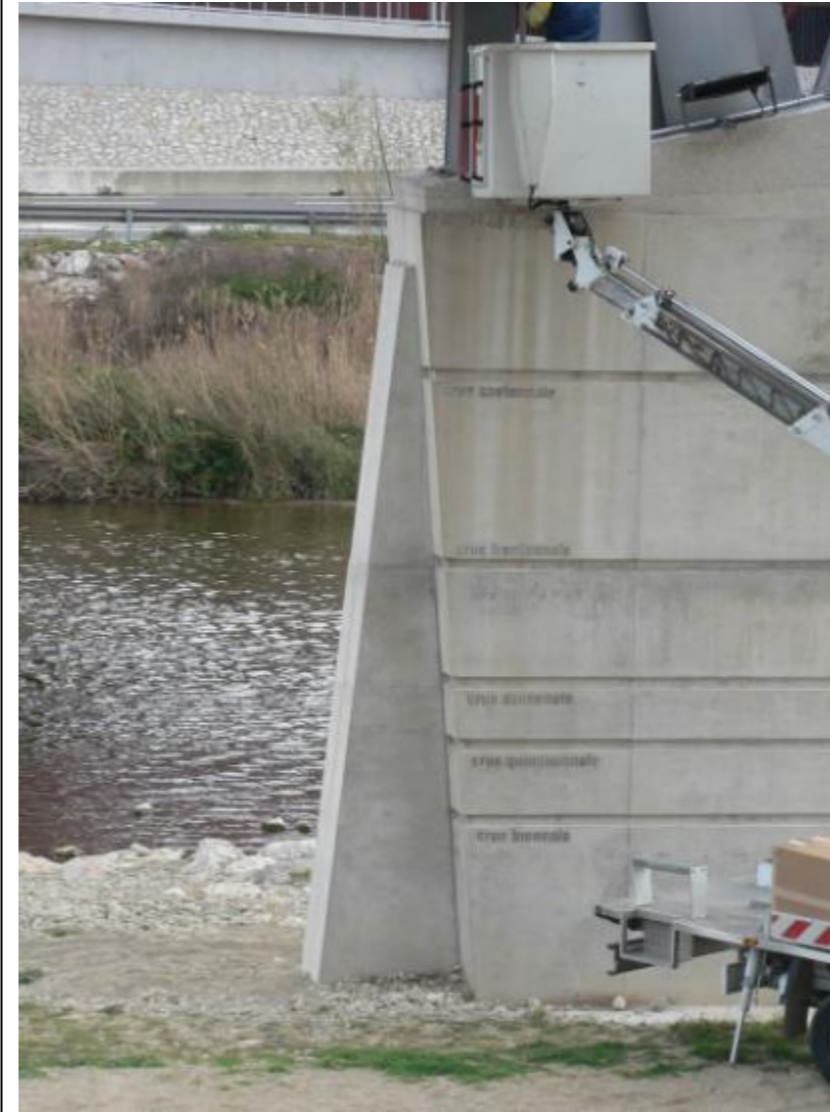
Les repères de crues sur la passerelle en amont du pont Joffre
