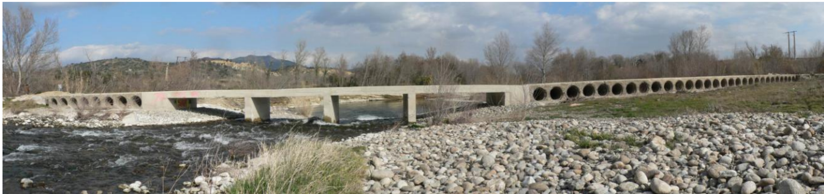
L'ouvrage passage à gué vue vers l'aval
