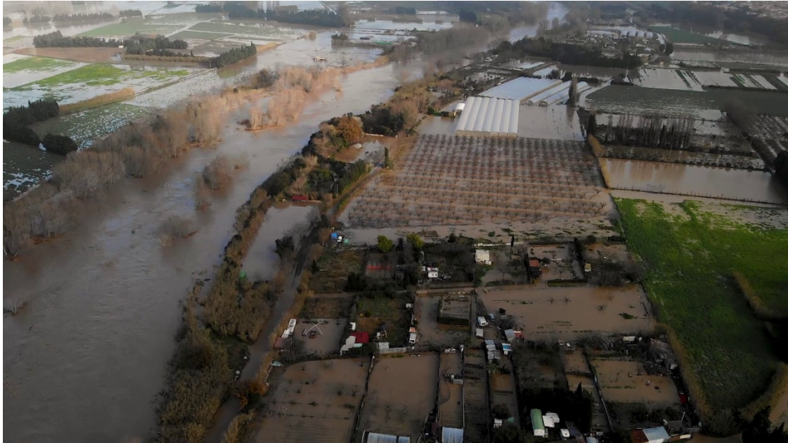
Figure 27 : Vue aérienne de la zone de débordements en rive droite au passage à gué de Villelongue-de-la-Salanque le 23/01/20 à 15h00
