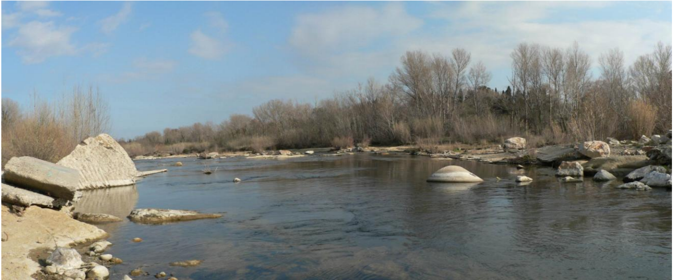
Vue du lit après la destruction du seuil servant de prise d'eau au canal des 4 cazals et du passage à gué de Baho - Vue vers l'aval depuis la rive gauche
