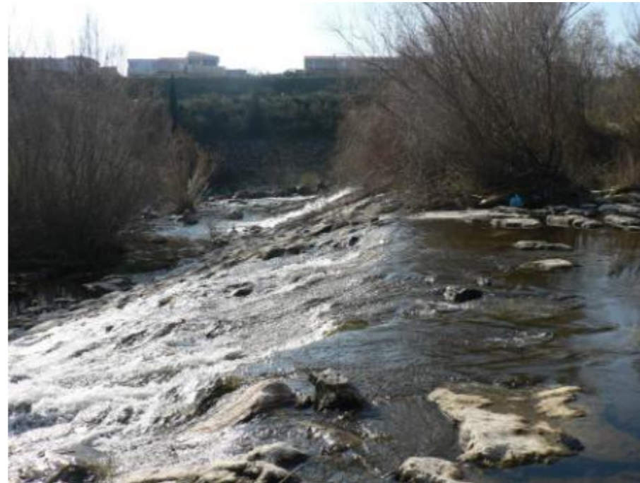
Le seuil de la prise d'eau du canal Vernet et Pia ROE 36269
