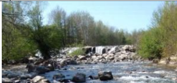
Seuil du de la prise d'eau du Canal du Vernet et Pia, vue vers l'amont
