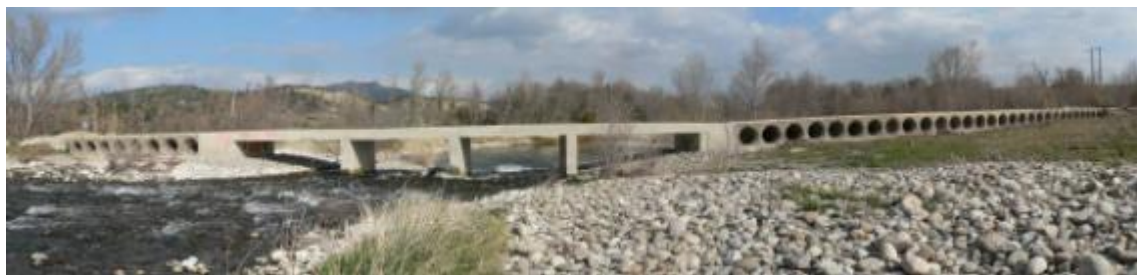
Passage à Gué de Néfiach (ROE 36341) – vue depuis l'amont
