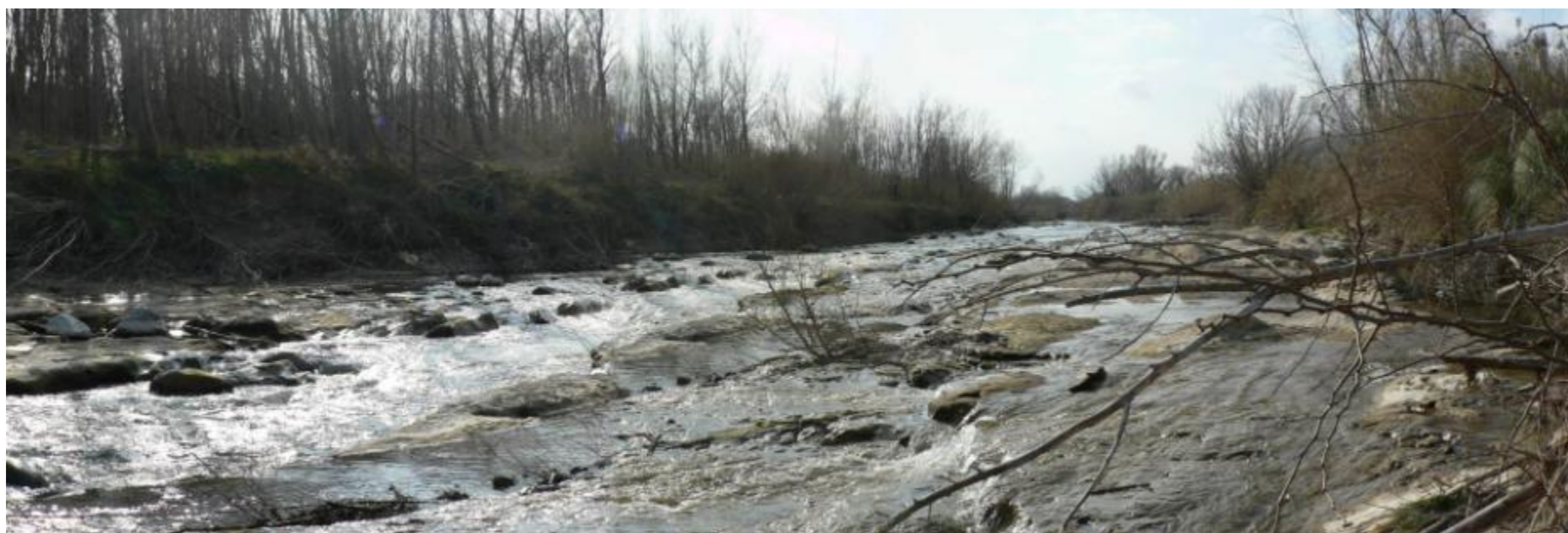
Vue vers l'amont, amont de l'ancien passage à gué de Baho – marque d'incision et d'érosion régressive suite à l'effondrement des deux ouvrages
