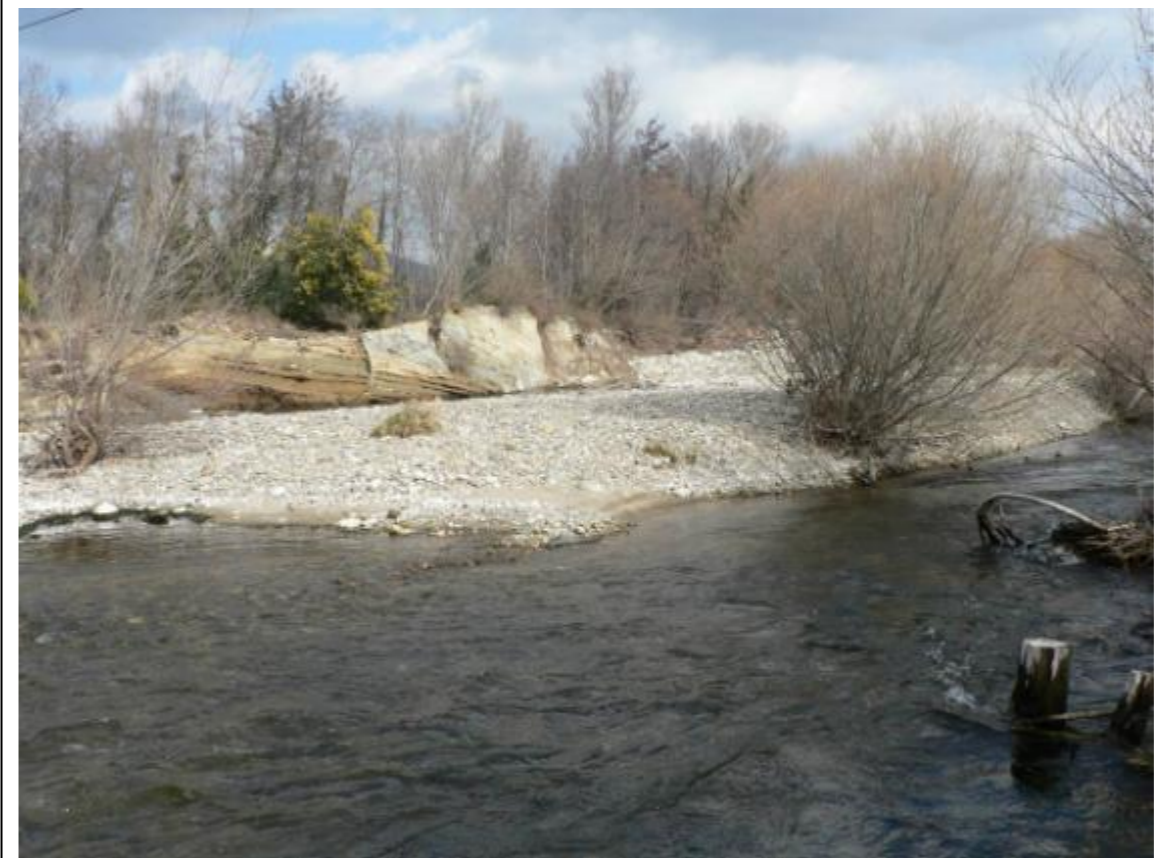
Erosion de berge en aval de la passe à poisson
