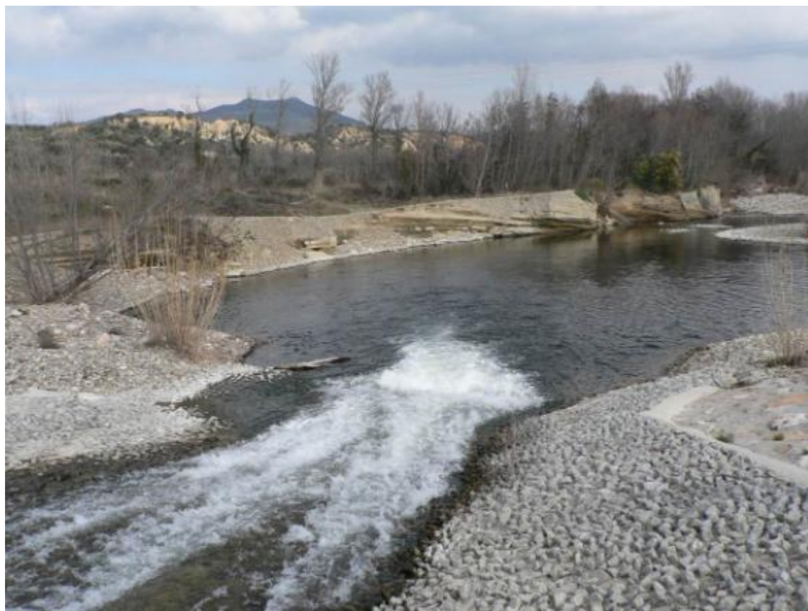
Passé à poisson et fosse de dissipation – vue vers aval
