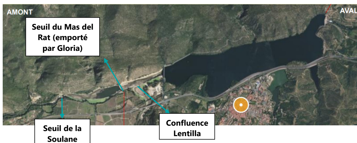
FIGURE 2 : DEUX SEUILS D'ARRET DES MATERIAUX EN AMONT DU BARRAGE DE VINÇA
