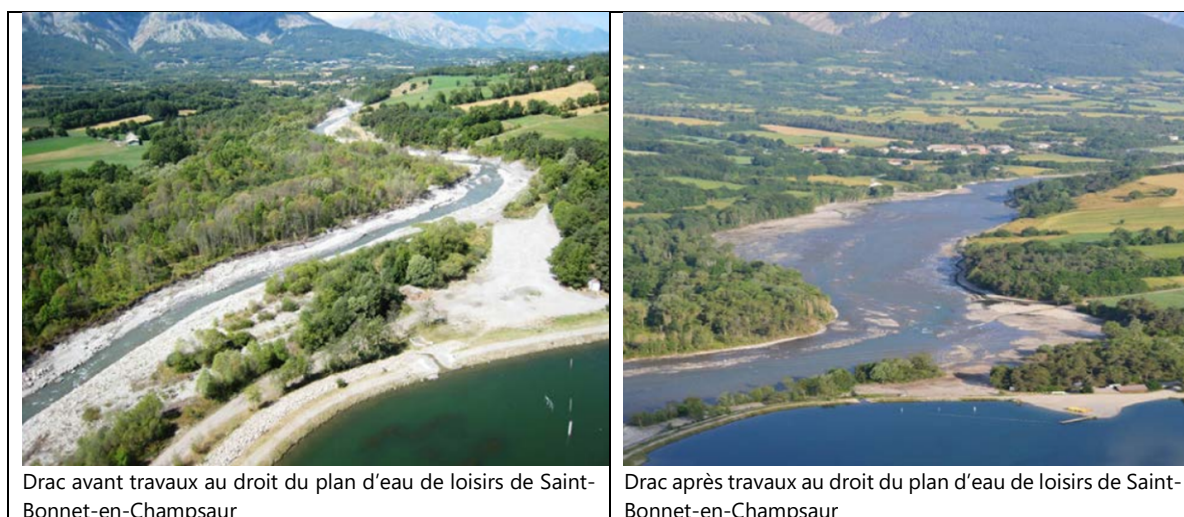
FIGURE 32 : RETOUR D'EXPERIENCE SUR LES REINJECTIONS DU DRAC
